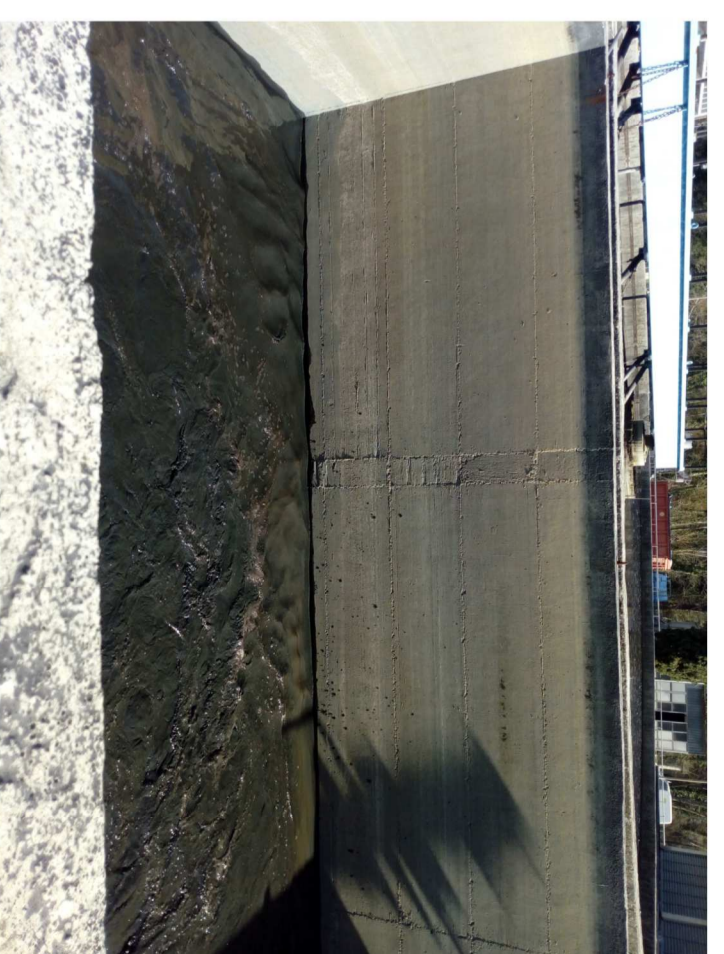
Vasca di digestione aerobica dei fanghi
